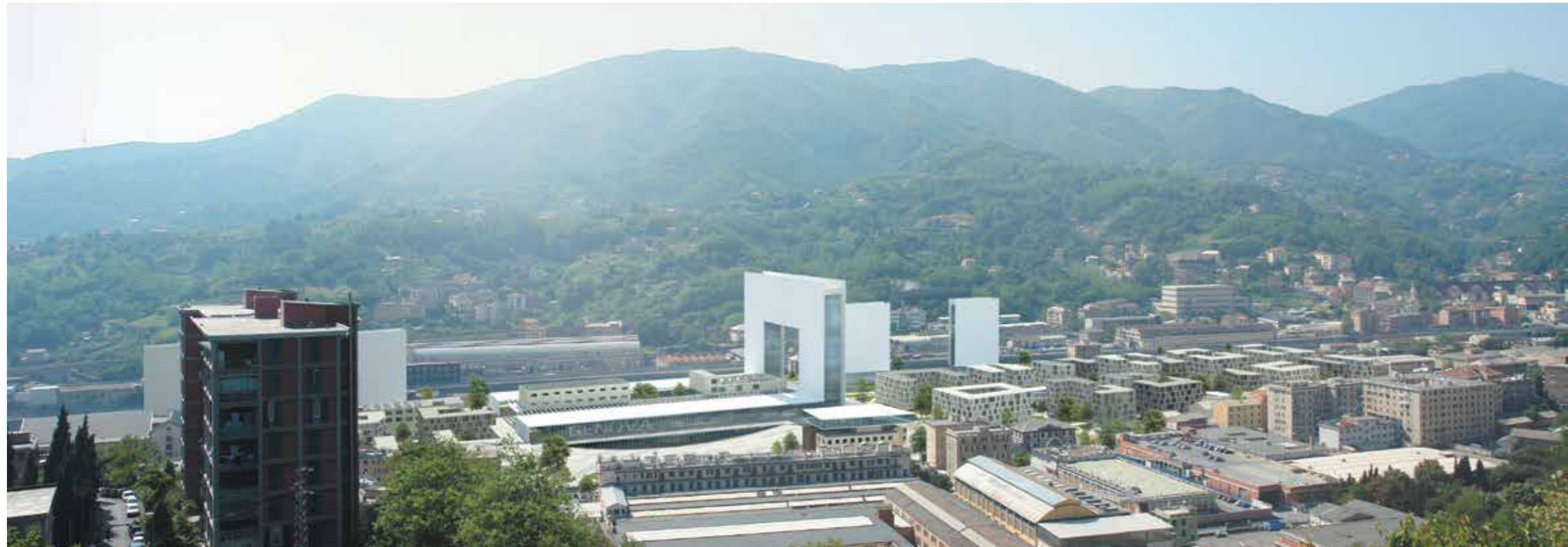
VISTA DELL'INTERVENTO SU RIVAROLO DALLA VAL POLCEVERA / VIEW OF THE INTERVENTION IN RIVAROLO DISTRICT FROM VAL POLCEVERA
